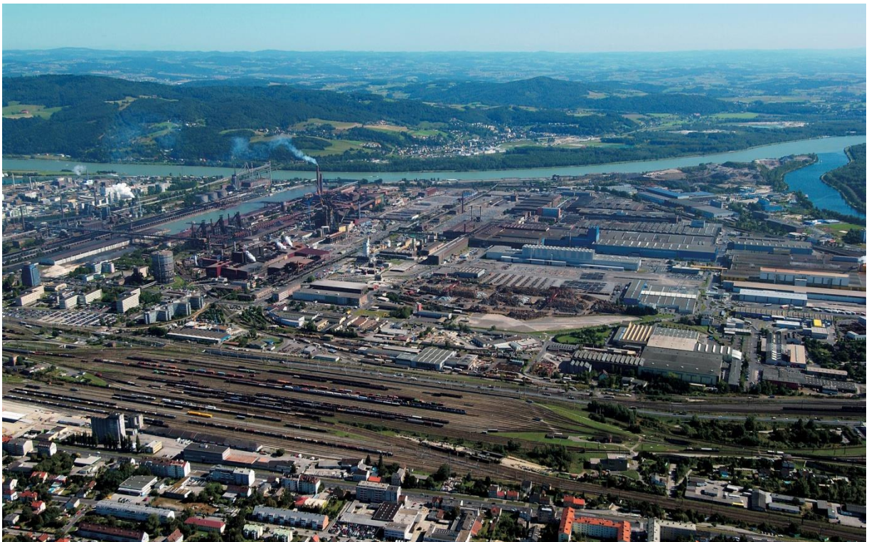
Abbildung 2: Luftaufnahme Werk Linz (Quelle: voestalpine)
